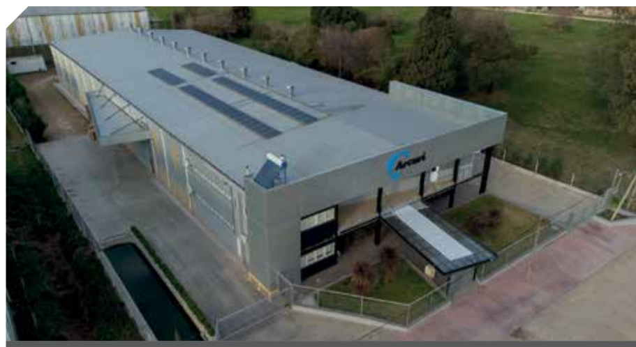
La estructura tiene 4.500 metros cuadrados, paneles solares y más de 3.000 posiciones.
